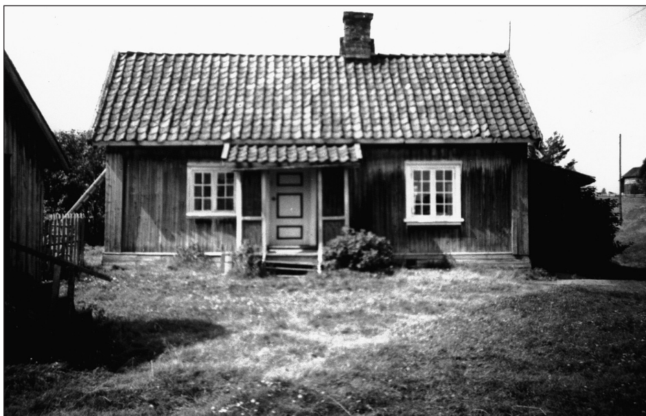
Det gamle huset i Nilsrud.
