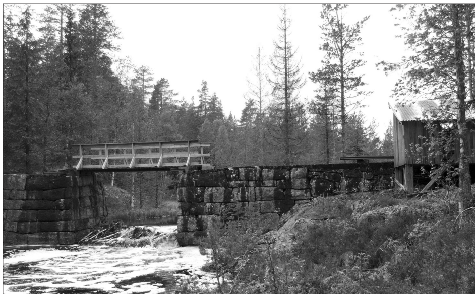
Midtre Grytdammen med lukehus og ny gangbru.
