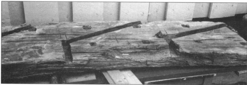
Del av vasshjulet funnet i hjulhuset med uthogde spor for skovlene.
